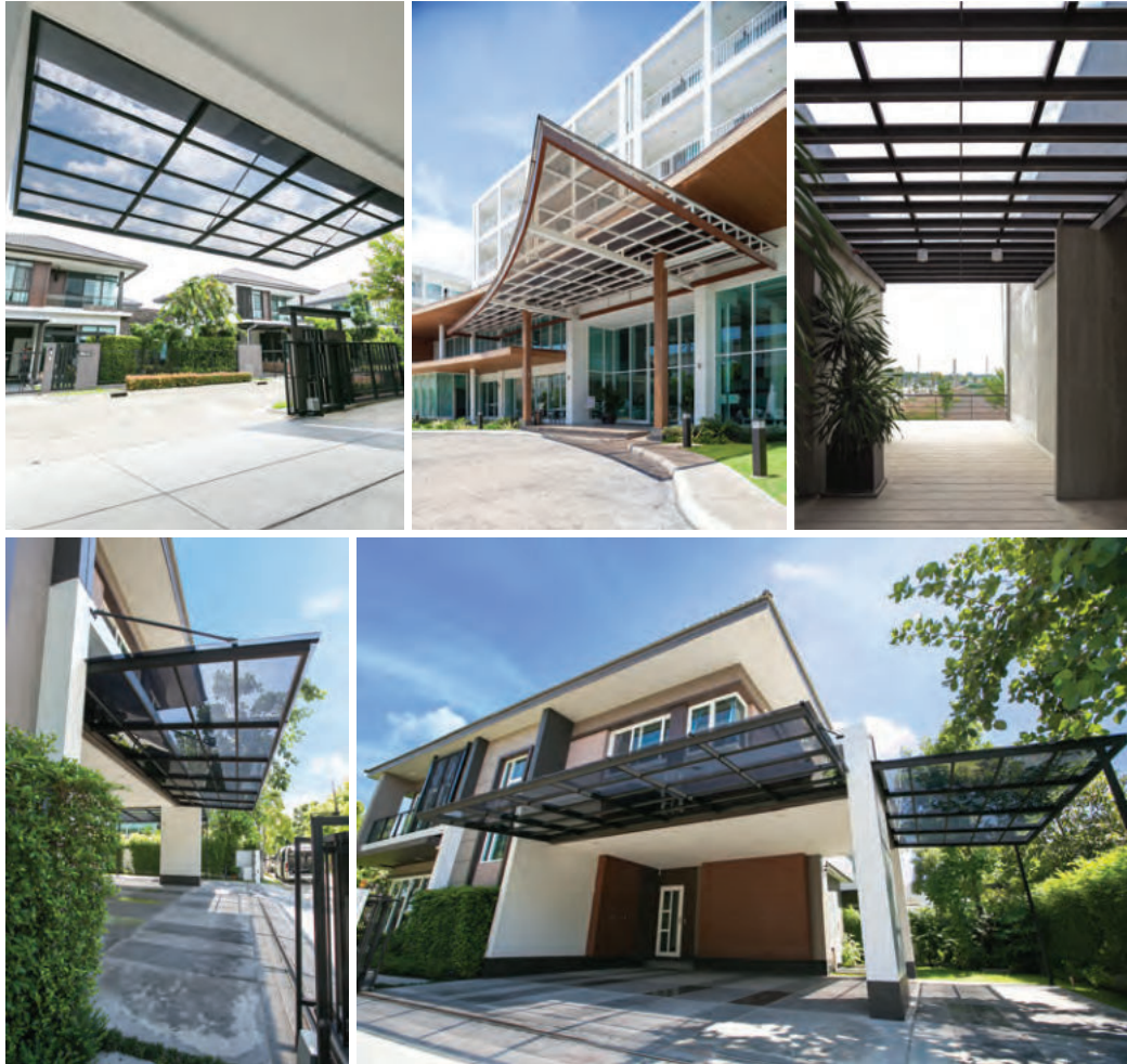
ภาพอาคารที่ติดตั้งหลังคาคลุมพื้นที่ส่วนหน้าอาคาร Shinkolite Acrylic
